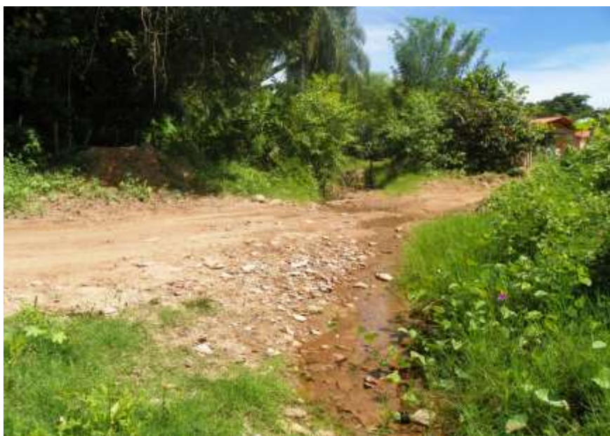
Figura 5.47 – Riacho Antônio de Lu (área de alagamento) – Distrito de Baixo das Palmeiras.
