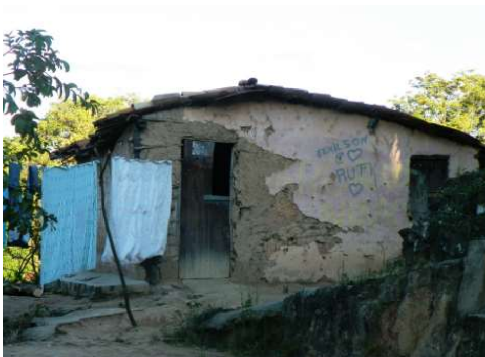
Figura 5.34 – Residência sem banheiro no distrito de Campo Alegre.
