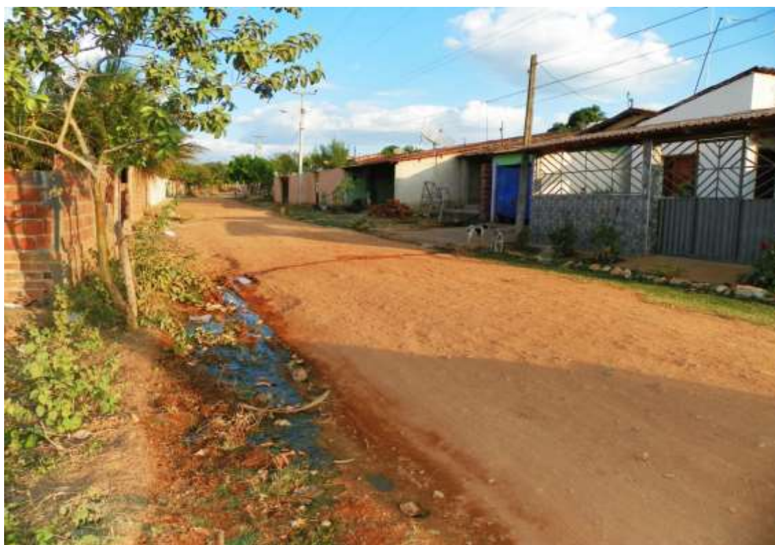
Figura 5.37 – Esgoto a céu aberto no distrito de Monte Alverne – Rua Antônio José Soares.
