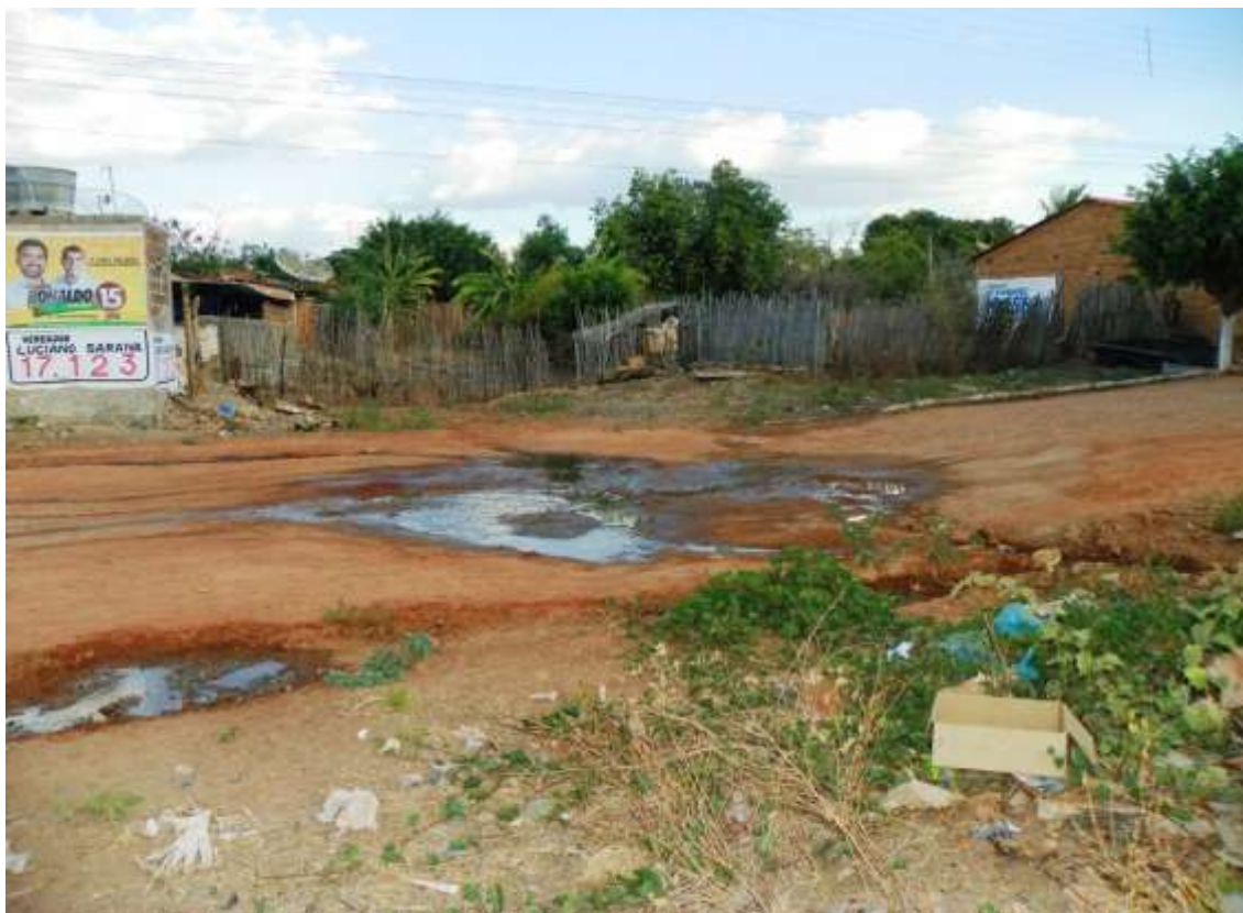
Figura 5.38 – Esgoto a céu aberto no distrito de Monte Alverne – Rua São Francisco.
