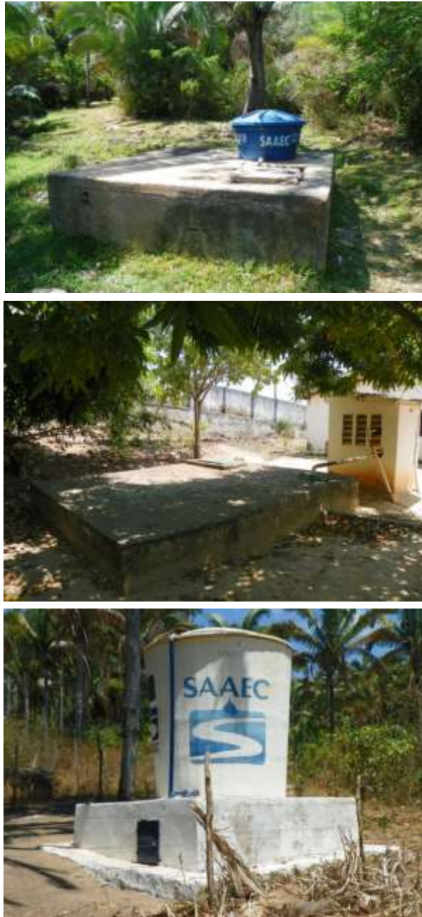
Figura 5.11 – Vista do fonte ( Q = 4,8 \text{ m}^3/\text{h} ), reservatório semienterrado RSE de 50 \text{ m}^3 e do REL de 10 \text{ m}^3 que fazem parte do sistema do distrito de Santa Fé, município do Crato, de responsabilidade da SAAEC.
