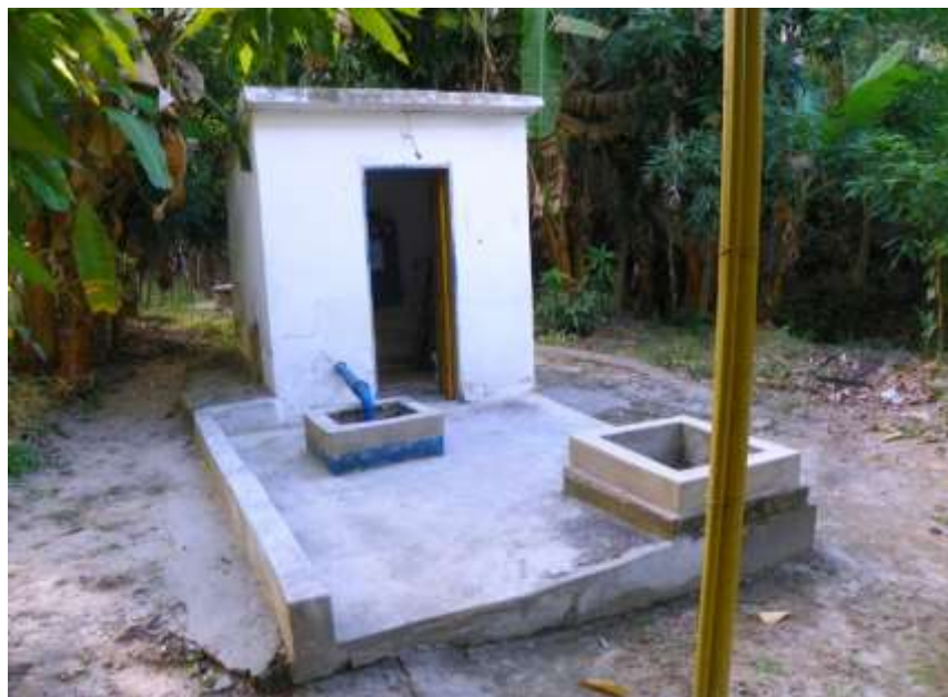
Figura 5.6 – Vista da fonte (Q desconhecida) e do RAP de 10 m 3 que fazem parte do sistema do distrito de Campo Alegre, município do Crato, de responsabilidade da SAAEC.
