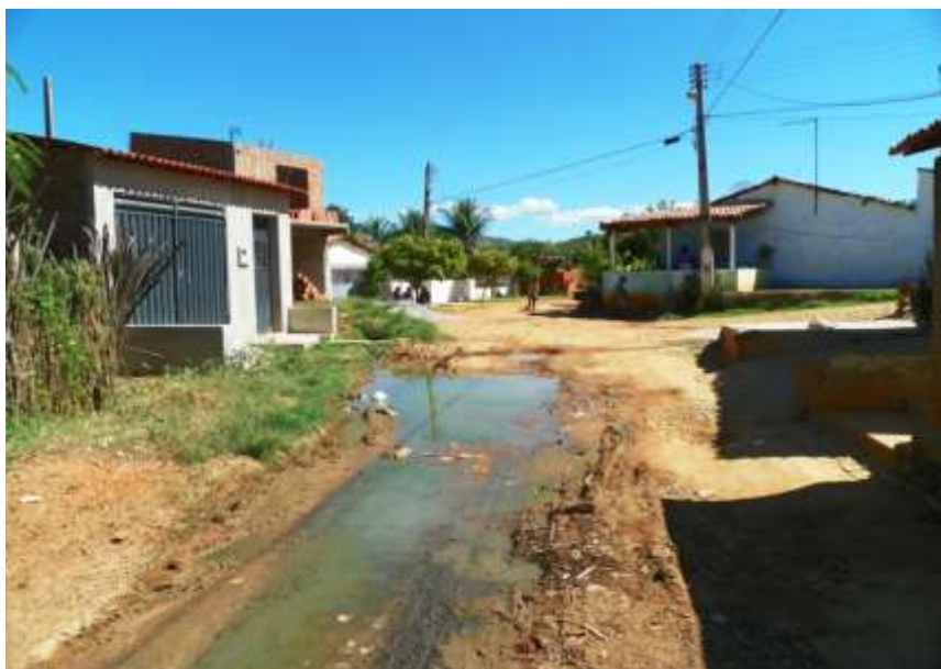
Figura 5.36 – Esgoto a céu aberto no distrito de Dom Quintino.
