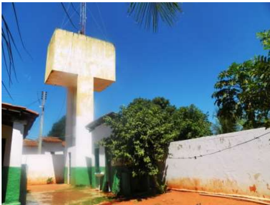
Figura 5.12 – Vista do poço tubular ( Q = 5,1 \text{ m}^3/\text{h} ) e do REL de 50 \text{ m}^3 que fazem parte do sistema do distrito de Santa Rosa, município do Crato, de responsabilidade da SAAEC.
