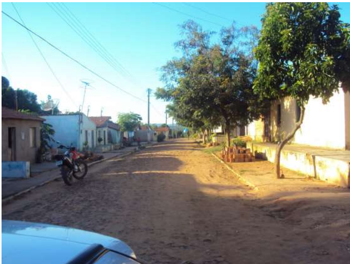
Figura 5.39 – Esgoto a céu aberto no distrito de Bela Vista.
