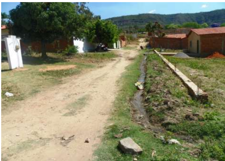
Figura 5.33 – Esgoto a céu aberto no distrito de Belmonte – Rua João Hélio.
