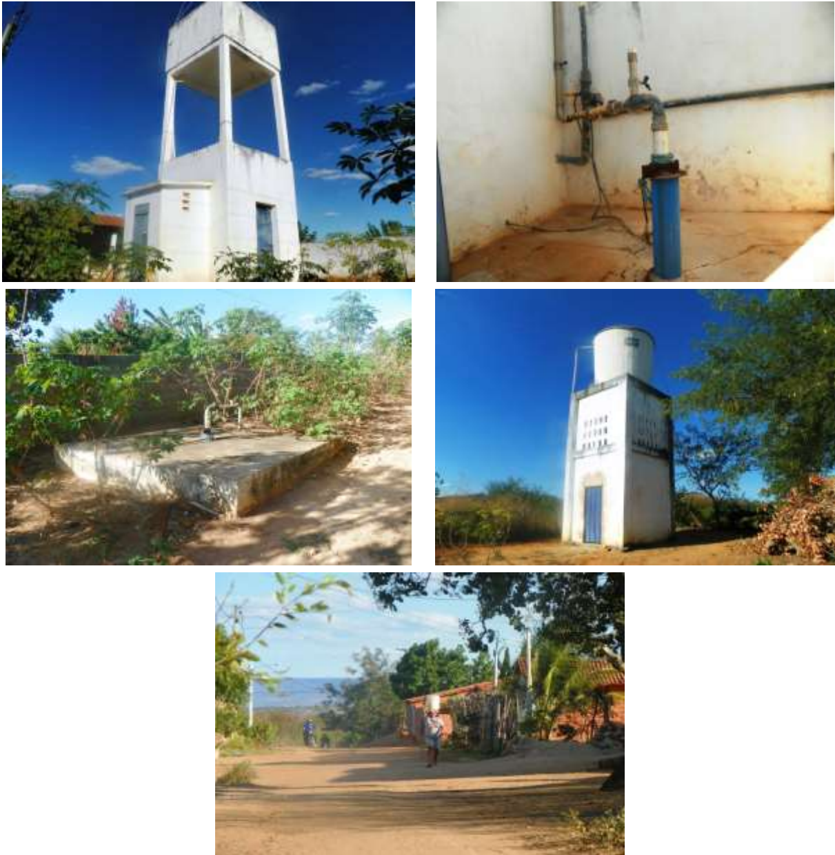
Figura 5.9 – Vista dos poços tubulares PT-01 ( Q = 11,8 \text{ m}^3/\text{h} ) e PT-02 ( Q = 9,0 \text{ m}^3/\text{h} ) e dos reservatórios elevados REL-01 e REL-02 de 10 \text{ m}^3 que fazem parte do sistema do distrito de Bela Vista, município do Crato, de responsabilidade da SAAEC. Observa-se que muitas residências não possuem abastecimento por rede.
